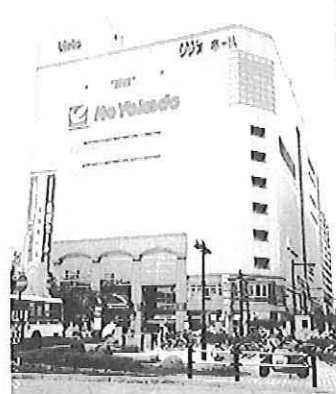
アモール・トローワでは亀有駅南口に建つイトーヨーカ堂のビルメンテナンスの仕事を請け負っている。
