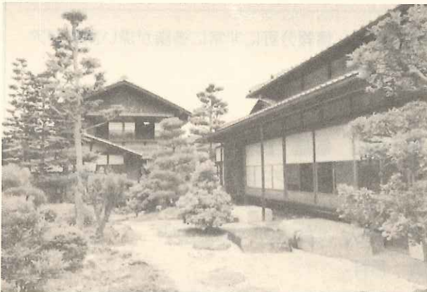
東近江市五個荘金堂町（重要伝統的建造物群保存地区）の一角にあるツカキグループ社長、塚本喜左衛門氏の本宅は明治初年頃築。母屋と離れと庭、三つの蔵からなり、付近の町並みととけあって、近江商人の歴史と心意気を醸し出している。
