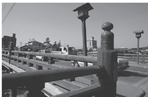
盛岡市上の橋
